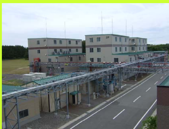
(工場内プラント風景)
