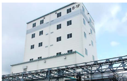
2012年に完成した新設備
