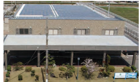
金沢工場 事務棟の屋根に設置された太陽光パネル
