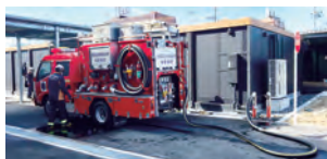
事業所だけでなく近隣での火災発生にも対応可能な消防用消火栓を設置しています。
