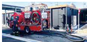
事業所だけでなく近隣での火災発生にも対応可能な消防用消火栓を設置しています。
