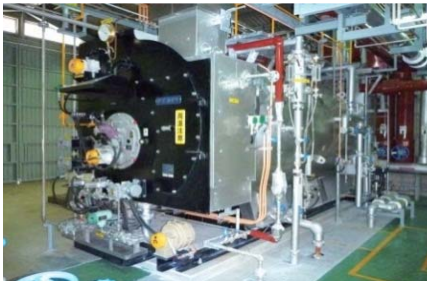
▲ 金属含有副生油対応型有価金属回収ボイラー(副生油処理システム)
