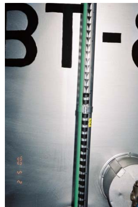
【タンク液面計の改良】
