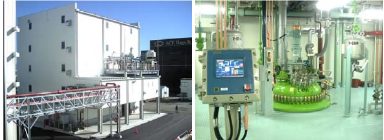
パイロットプラント設備(金沢工場)
