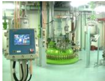
パイロットプラント設備(1月完成)
