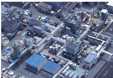
再整備中の大阪工場
