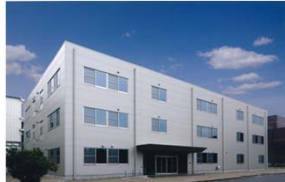
新研究棟を 金沢工場に建設(2009/7月)
