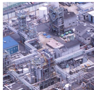
移管を進める大阪工場製造設備
