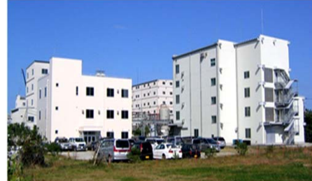
化成品事業集約の金沢工場
