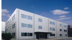
新研究棟を 金沢工場に建設(2009/7月)
