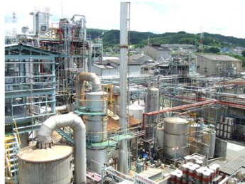
再整備中の大阪工場
