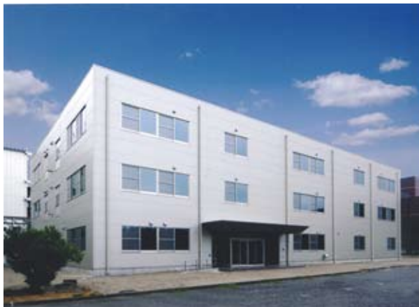
完成した新研究棟
