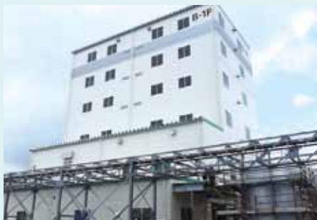
完成した新設備(酒田工場)
