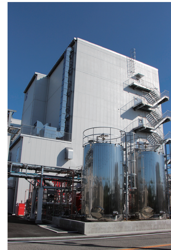
【半導体材料 製造設備（新設）】
